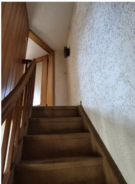
Treppe zum Dachgeschoss
